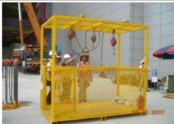
Crane man box
